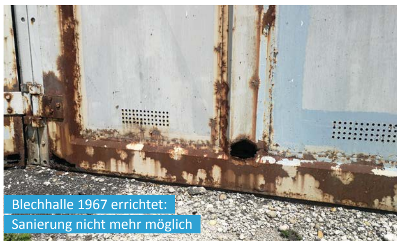
Abbildung 14: Außenwand der Panzerhalle
