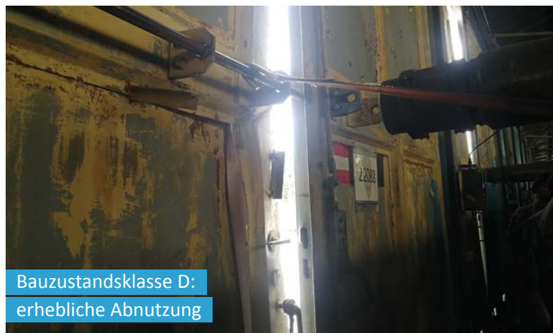
Abbildung 13: Defektes Tor
