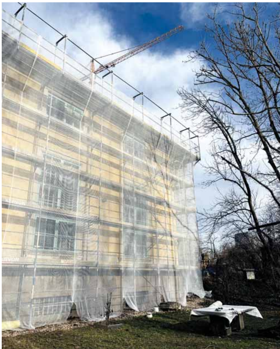
Sanierung der Praterateliers, Ansicht Nordpavillon
