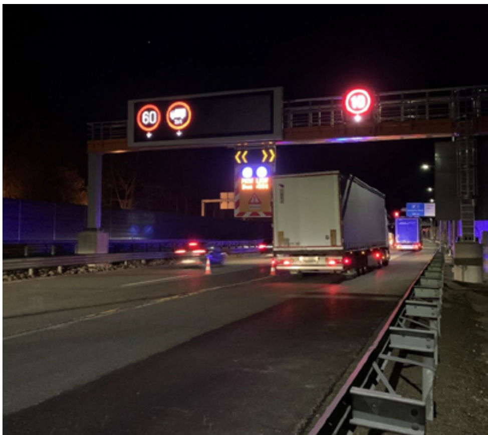
Abbildung 10: Schiebeschild als High- light der automatischen Dosieranlage
