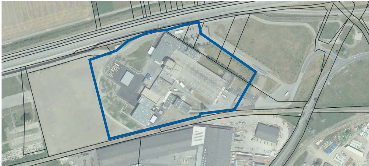
Abbildung G: Umspundung des Werksgeländes des privaten Unternehmens
