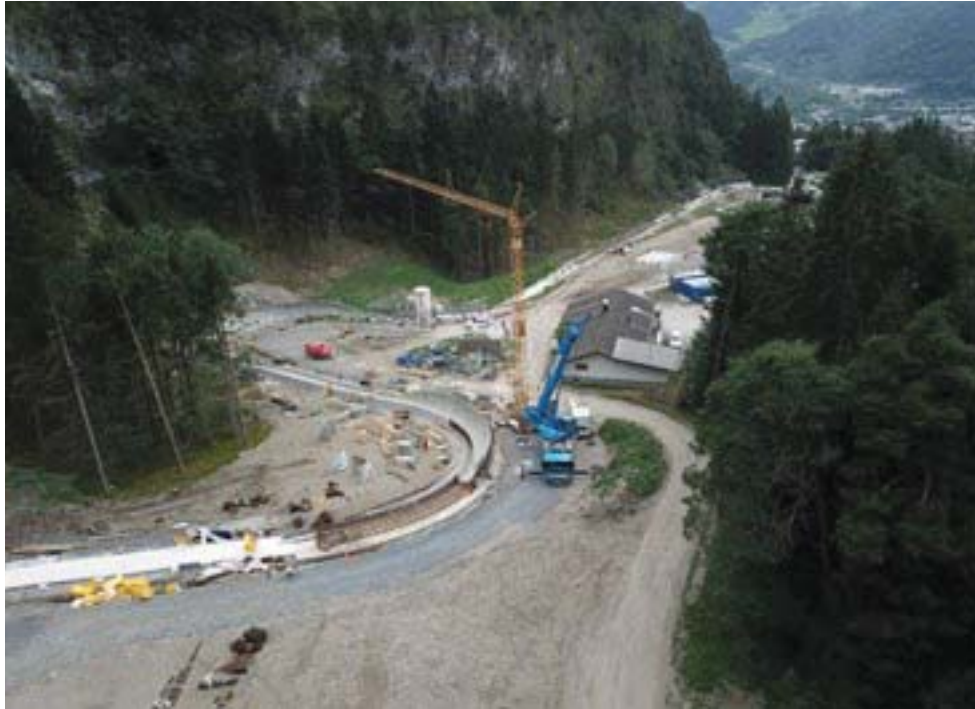
Eiskanal Bludenz während der Bauarbeiten im Jahr 2020.
