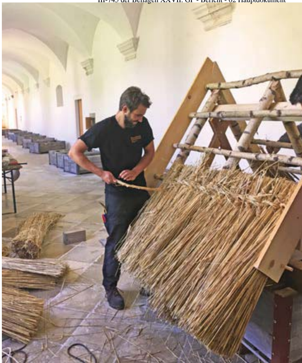
Strohdachdeckung, Kreuzgang der Kartause Mauerbach
