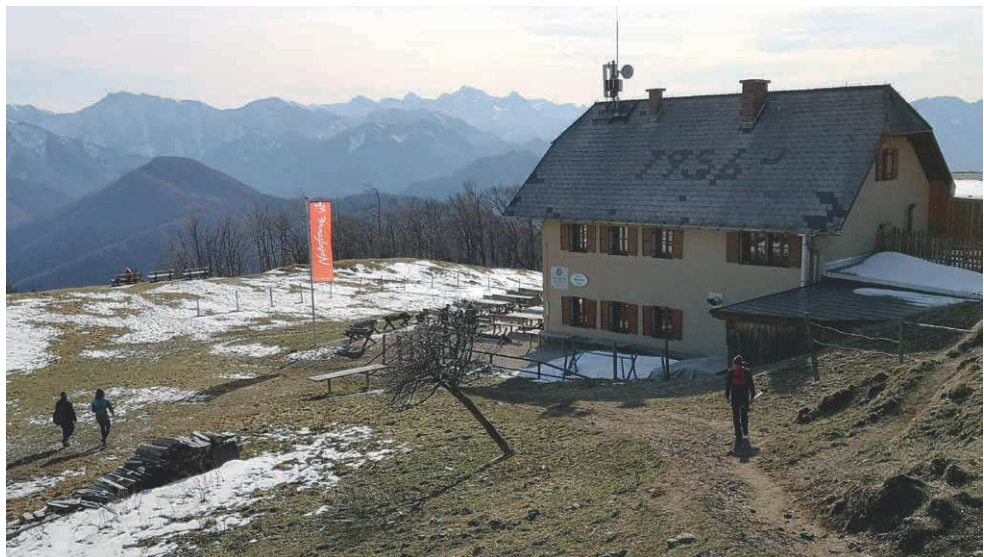
Sanierungsbedürftige Schutzhütte im Alpenvorland
