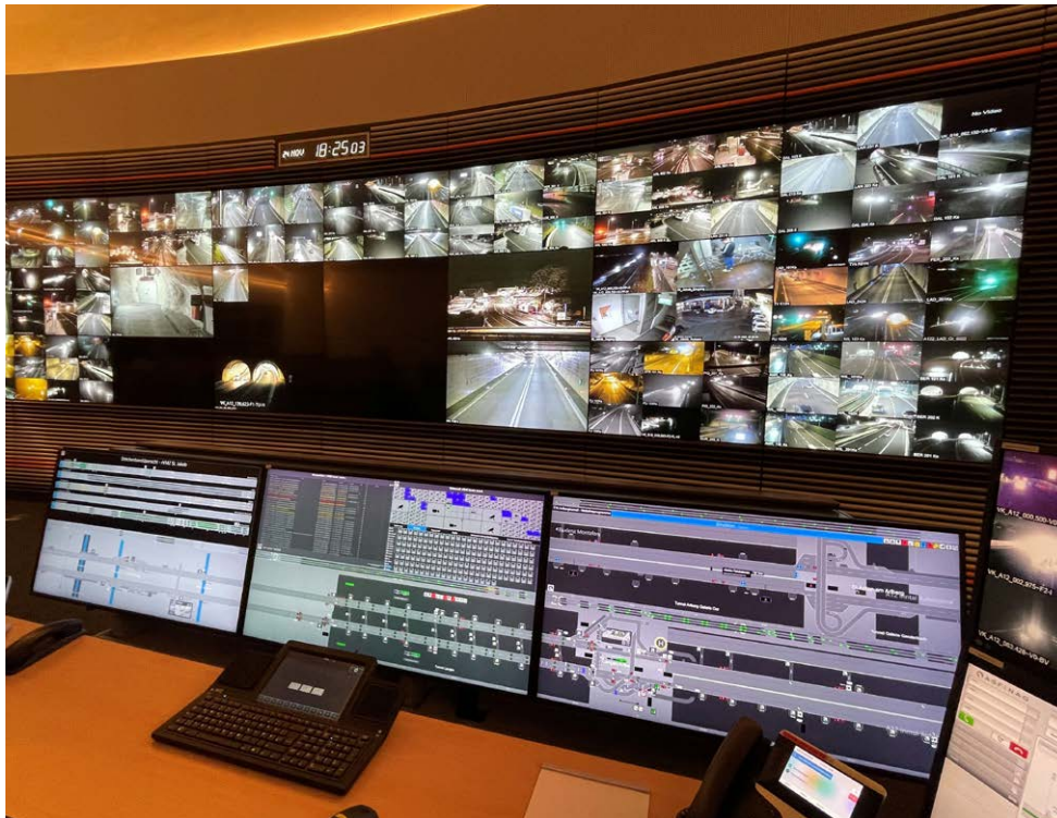
Abbildung 16: Verkehrsmanagementzentrale Klagenfurt © ASFINAG
