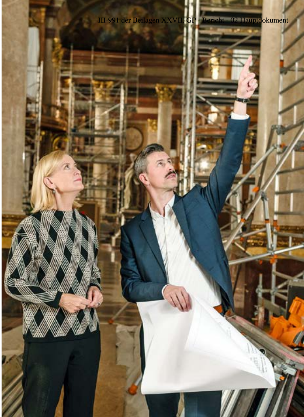
Renovierungsarbeiten im Prunksaal
