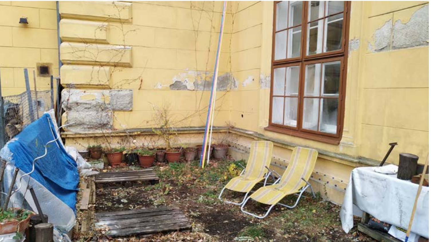
Südpavillon der Praterateliers, Zustand vor der Sanierung
