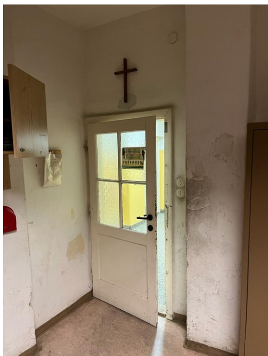
Bild 3: Aufenthaltsraum in der Liechtenstein- Kaserne Allentsteig
