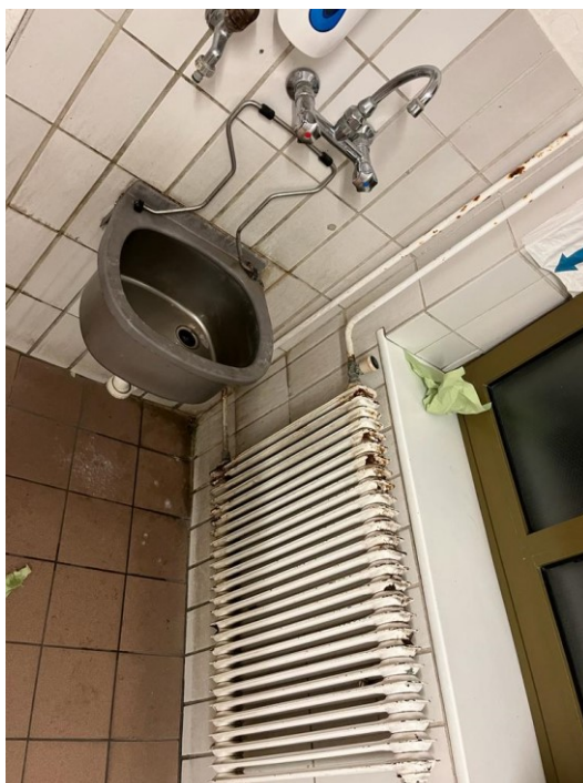
Bild 2: Waschraum in der Liechtenstein- Kaserne Allentsteig
