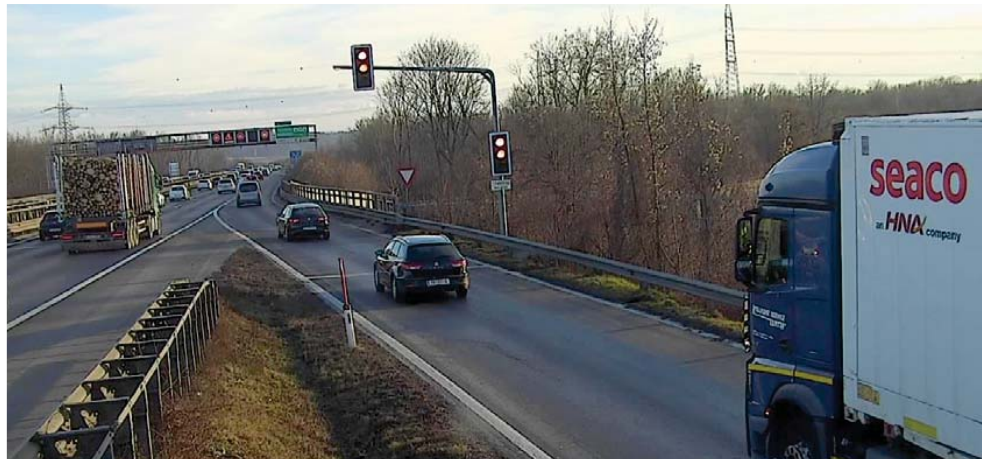
Abbildung 24: Zuflussregelungsanlage auf der A7 © ASFINAG
