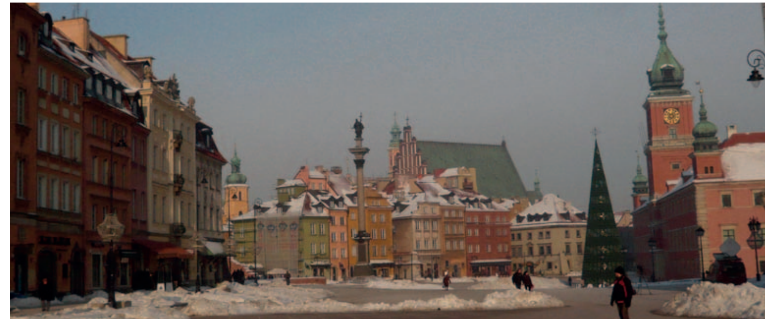
Die Warschauer Altstadt mitsamt Königsschloss wurde in einem nationalen Kraftakt wieder aufgebaut
