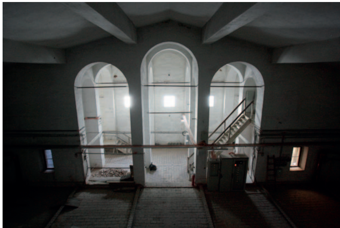
11. November 2010: Dachgeschoss über dem Lokal VI (Budgetsaal), möglicher Ausbauraum im Zuge der geplanten Sanierung des Parlamentsgebäudes
