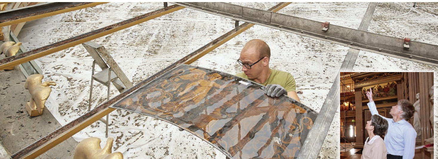
Vorgriff auf die Gesamtsanierung: NR-Präsidentin Prammer und Parlamentsdirektor Dossi begutachten die Sicherungsarbeiten am Glasdach im Historischen Sitzungssaal 2013 © Parlamentsdirektion/Zolles KG/Mike Ranz
