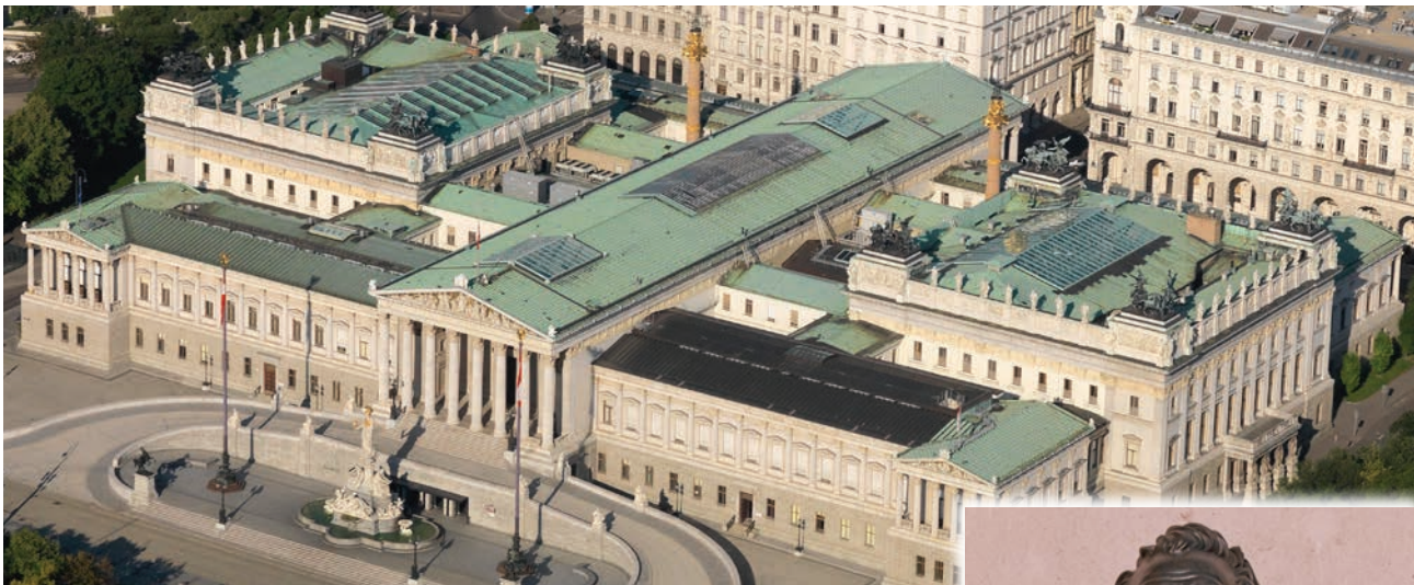
Die Dachlandschaft des Parlamentsgebäudes ist ein zentraler Aspekt bei der unumgänglichen Sanierung © Parlamentsdirektion/Bildagentur Zolles KG/Mike Ranz
