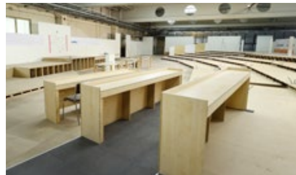
Wegen des knapp bemessenen Zeitrahmens wurde das gesamte Podest samt Tischreihen in einer Halle in Schwechat eins zu eins vorgefertigt, sodann zerlegt und in der Hofburg wieder zusammengebaut. © Parlamentsdirektion/Johannes Zinner
