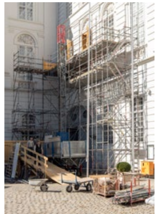
Zusätzliche Erschwernis: Aus Rücksicht auf die historische Bausubstanz musste das gesamte Baumaterial über zwei kleine Fenster eingebracht und in der Folge händisch über Rampen weitertransportiert werden. © Parlamentsdirektion/Michael Buchner
