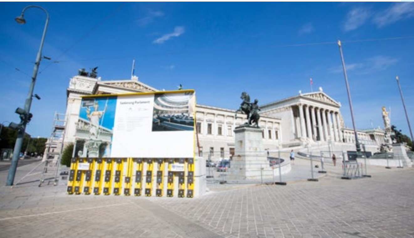
Die Bautafel vor dem Parlamentsgebäude markiert den Sanierungsbeginn. © Parlamentsdirektion/BKA/Christopher Dunker
